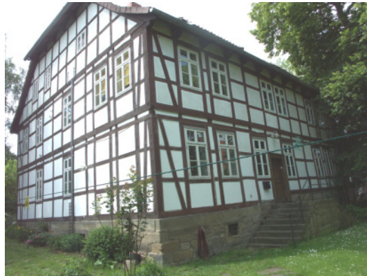
Abbildung 9 Fachwerkgebäude mit Rittersaal
