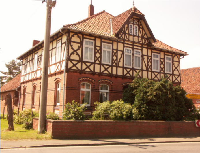
Abbildung 6 Villenartiges Wohnhaus um 1900
